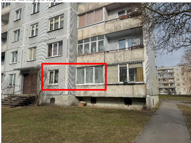
Skats uz dzīvokļa logiem no mājas fasādes puses.
